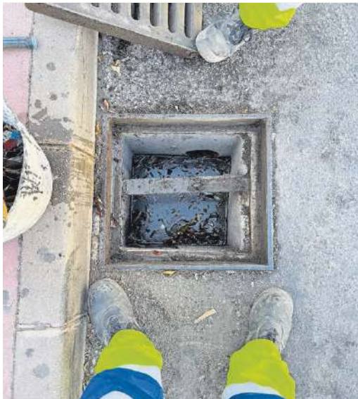
Trabajos en las arquetas de la localidad.
