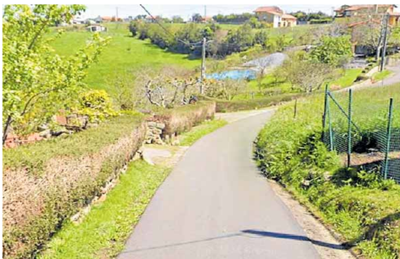
Zona en la que se llevarán a cabo los trabajos. E. c.
